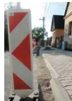
Zrekonštruovali sa aj chodníky na Vrančovičovej.
